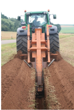
Grabenfräse + Verlegung der Wärmerohre
