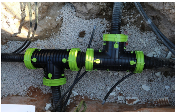
T-Stück im offenen Graben
