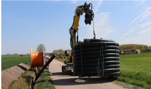
Grabenfräse + Verlegung der Wärmerohre
